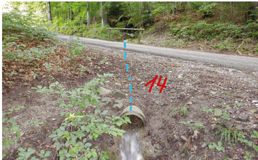
Abb. 37 Durchlass unter dem Zimmerwaldweg (Einleitung des Hofmattgrabe in den Hübeligrabe)
