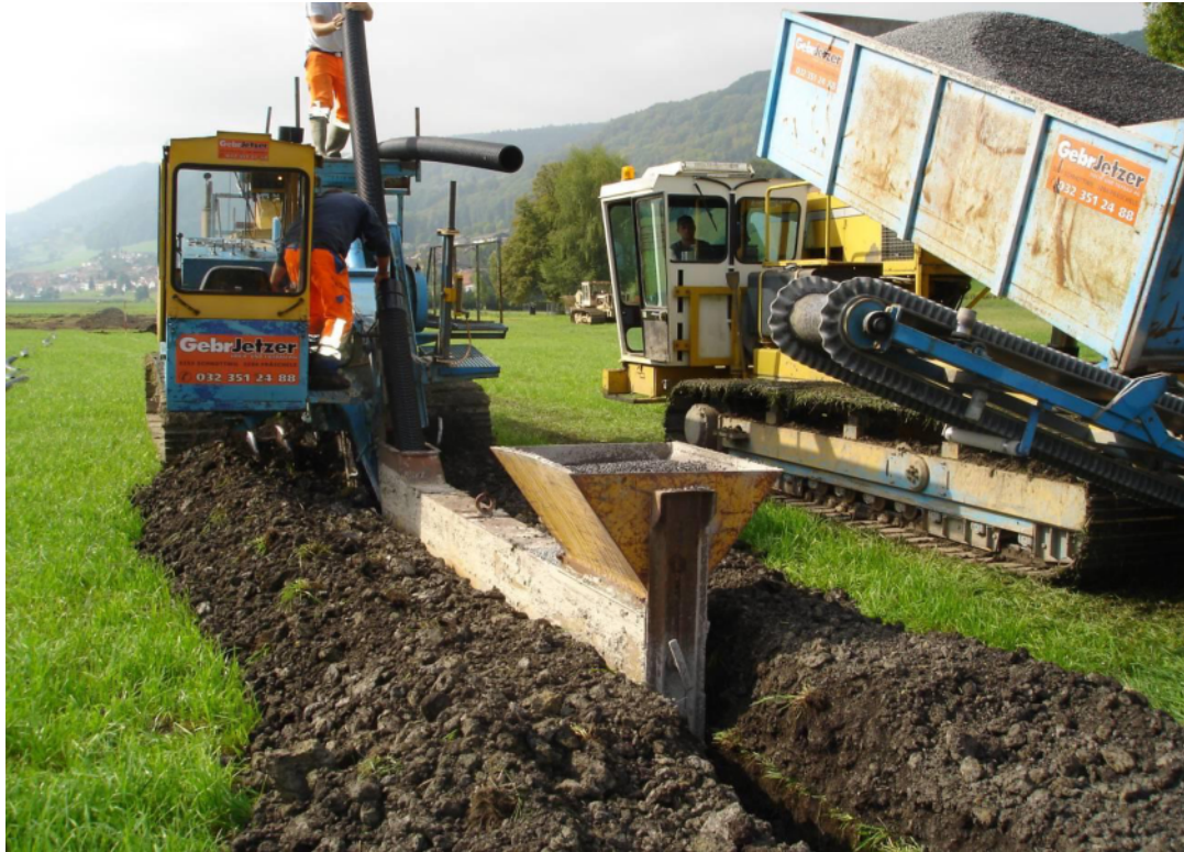
Abbildung 3: Verlegen von Drainagerohren mittels Grabenfräse. Das Rohrumhüllungsmaterial (Filterkies) wird mit einem Raupendumper eingebracht.
